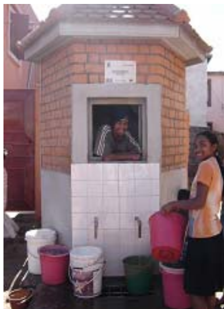
Les business plans aident les Associations des Usagers de l'eau à investir dans de nouvelles infrastructures. Cette nouvelle borne fontaine a été construite par Manja, une Association des Usagers de l'Eau du fokontany de Manjakaray.
