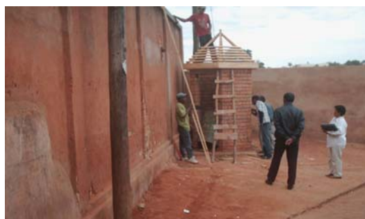
La construction de nouvelles bornes fontaines (en haut) réduit les files d'attente pour l'eau (ci-dessus)
